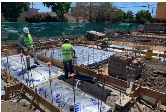
(C) 基礎工事等の実施（～2019年6月頃）
