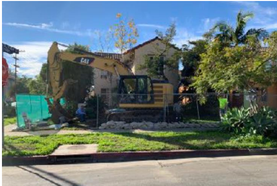
(A) 既設建物の解体工事（2018年12月頃～）
