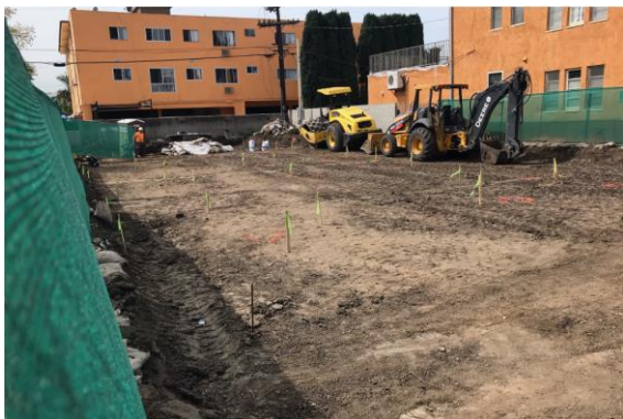
(B) 解体工事、整地作業（～2019年4月頃）
