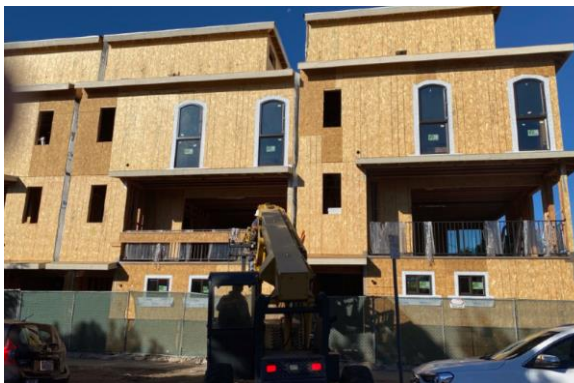
(E) 外壁工事等の実施（～2019年11月頃）
