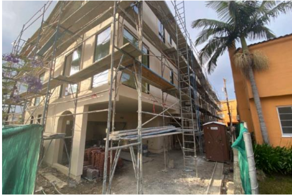
(G) 外装・内装工事の実施（～2020年5月中旬頃）
