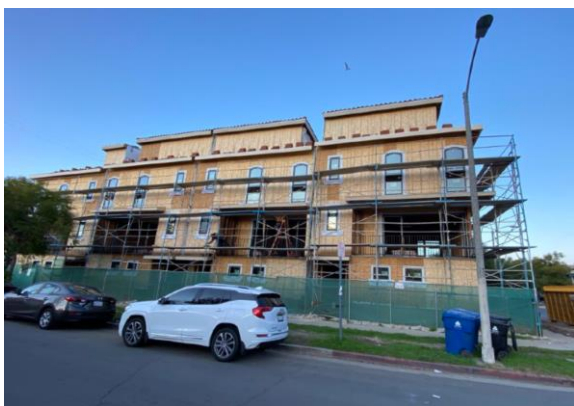
(F) 配管配線工事等の実施（～2020年1月頃）
